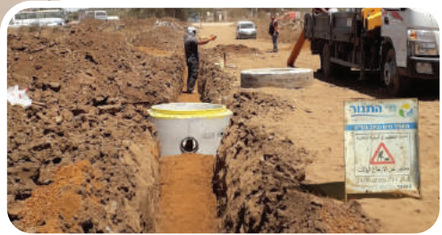
مسعده - أعمال في منطقة حفور
